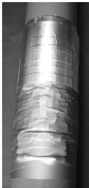
写真32 共振用コイル部分に防食テープを巻く
