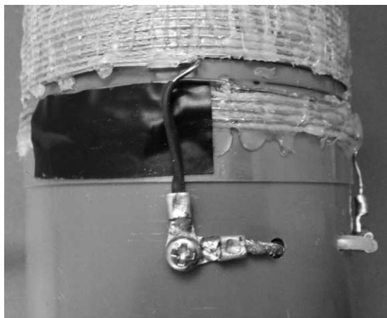
写真29-2 四つあけた穴の左から2番目の穴から、塩ビ・パイプの中を通した3D-2Vのシールド線(網線)を出して4mm用の圧着端子を取り付ける
