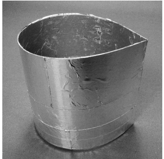
写真16-4 続いて内側に折り曲げて張っていくが、張った後ドライバの柄などを使ってなるべく平らになるように形を整える
