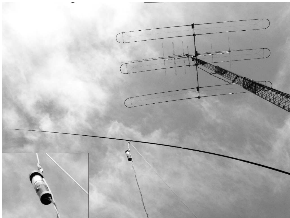
写真34-1, 写真34-2 ワールドワイドが扱っているW-GR-1800Hを使って地上高約12mにスーパー・ラド・アンテナを仮設
