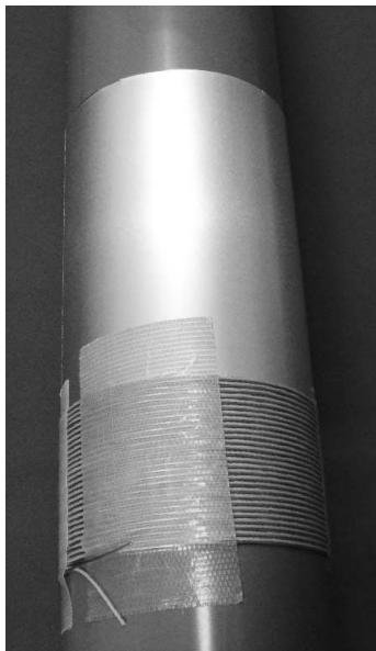
写真24 巻き数が30ターンになったら巻くのをやめる。ただし同軸ケーブルと接続する必要があるので10cm長めに残して切断する
