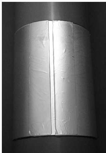
写真12-1 アルミ板が折り重なった 部分にアルミ・テープを張る
