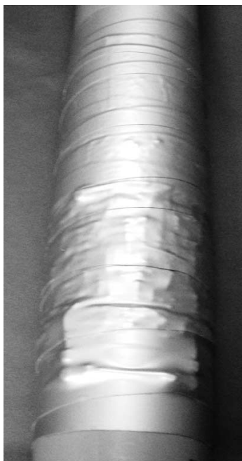
写真33 固定シリンダーと共振周波数調整用シリンダーの部分に防食テープを巻く
