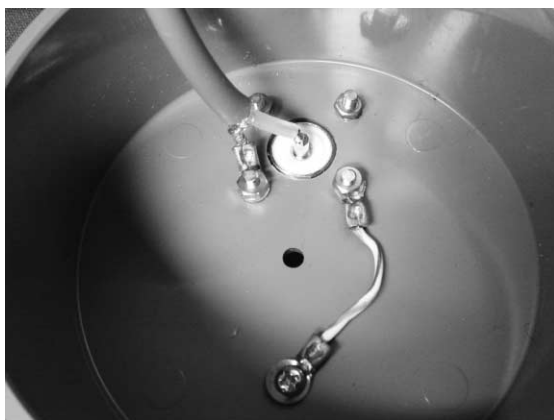
写真30 3D-2Vを適当なところで切断し、MJの座にはんだ付けする。MJの座とアース用端子を結線する
