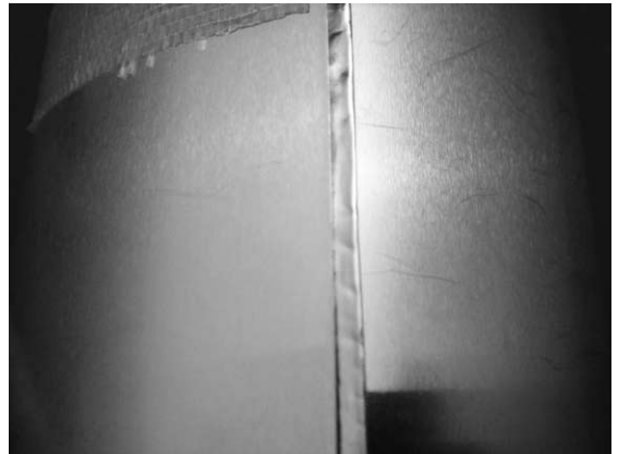
写真11-2 張り合わせたアルミ・テープをアルミ板の重なった部分に挟み込む
